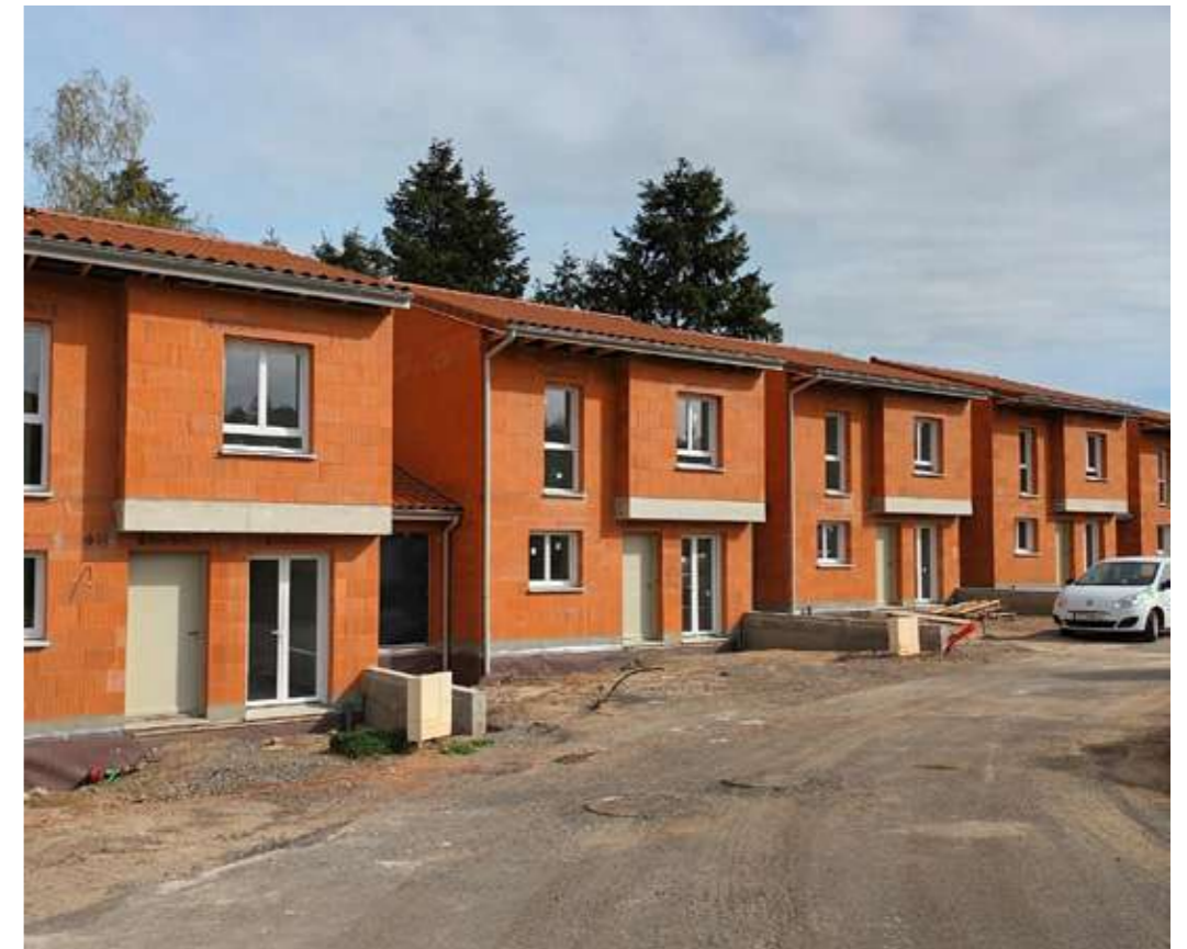
PAVILLONS EN CONSTRUCTION
